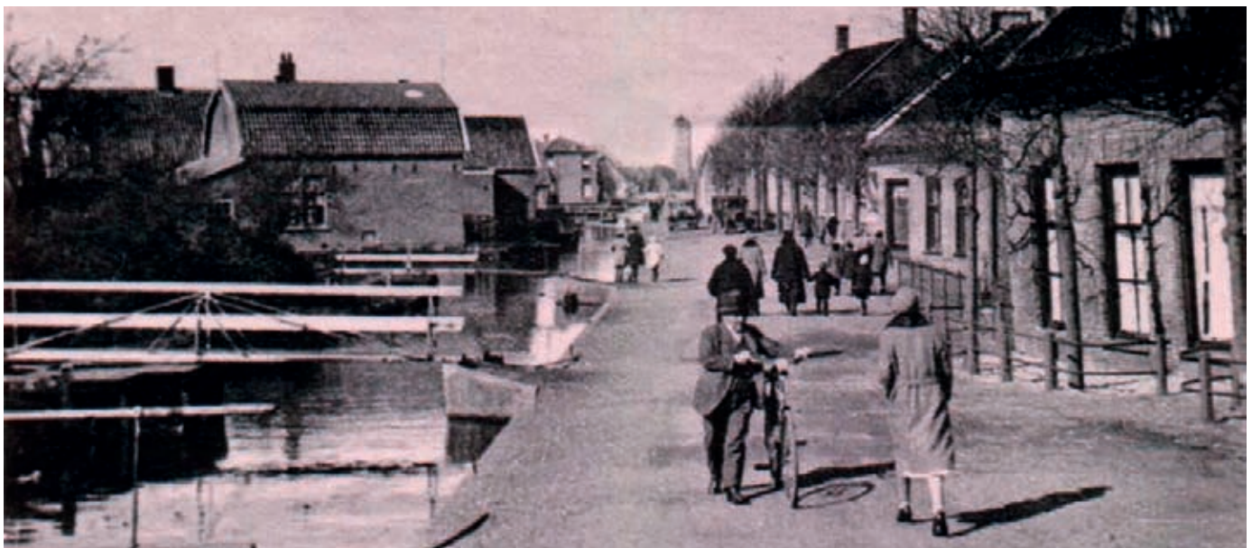
De Veenwetering in Roelofarendsveen functioneerde als riool én als drinkwatervoorziening.
