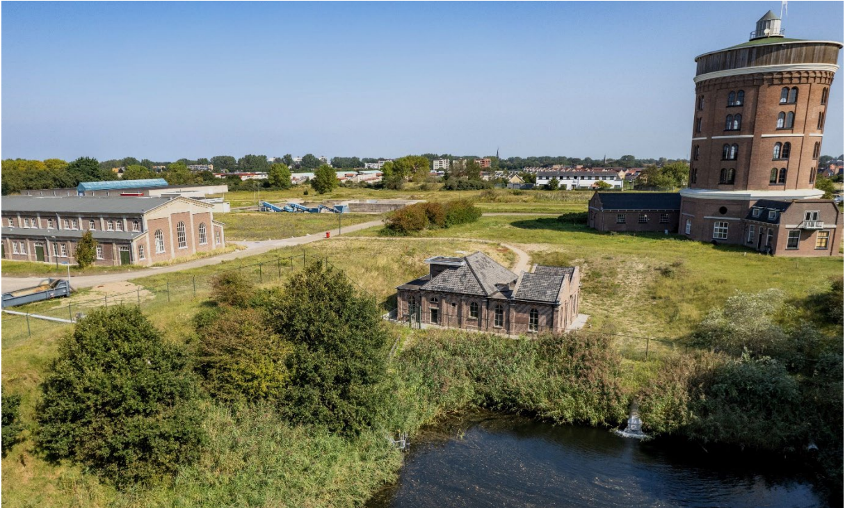
Afbeelding 9 Overzichtsfoto na de restauraties. Links op de foto het filtergebouw, vooraan het duinwater bassin met pompgebouw en de watertoren.
