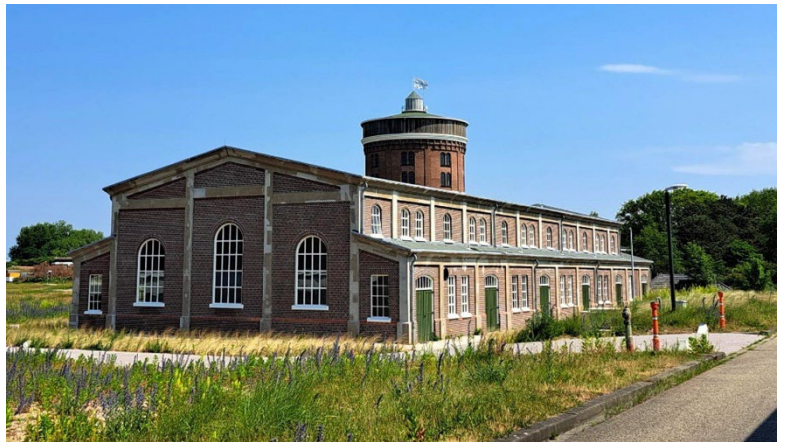
Afbeelding 5 Filtergebouw na restauratie 2021
