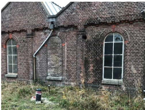
Afbeelding 7 Pompgebouw voor restauratie
