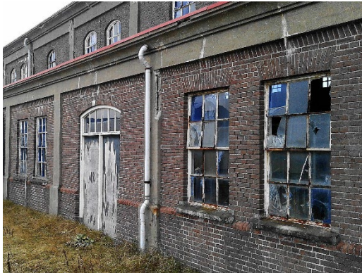
Afbeelding 4 Filtergebouw voor restauratie
