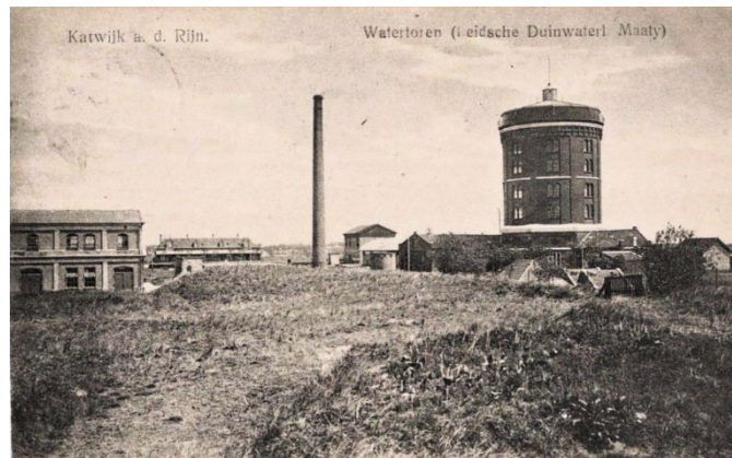
Afbeelding 3 Watertoren met links het filtergebouw en rechts voor de watertoren het pompgebouw, circa 1920.
