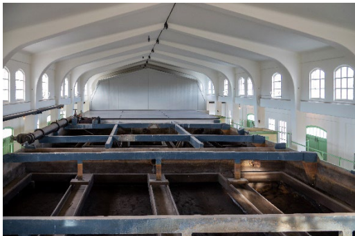
Afbeelding 6 Interieur Filtergebouw na restauratie 2021
