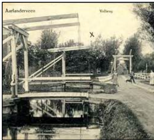
Een van de gevolgen was, dat een ringsloot moest worden aangelegd langs het Zuideinde en achter het dorp Aarlanderveen. Het leverde de nodige bruggen op, zoals hier aan de rechterkant over de ringsloot in het Zuideinde. (collectie A.J.J. van 't Riet)
