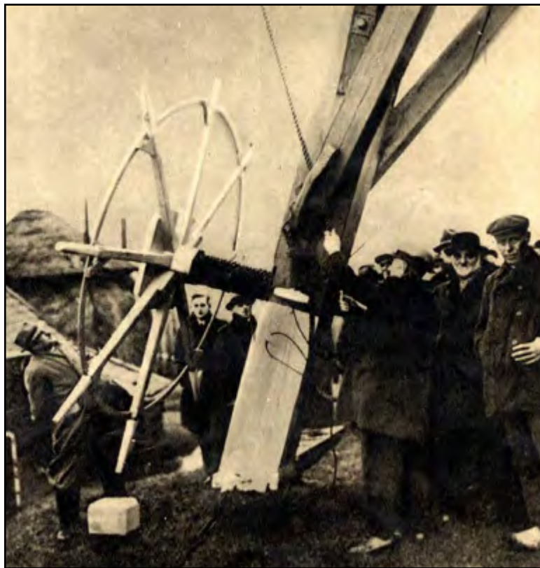
In 1936 werden de wieken van de molens 'Verdekkerd'. In december 1936 werden op de Putmolen de bestuurders uitgenodigd om het nieuwe systeem in werking te zien. (collectie J. Slingerland)
