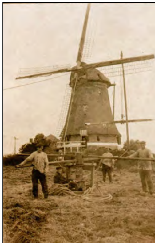
Onderhoud aan de molens is van alle tijden. Molenmakers bij de windas, ook wel kaapstander genaamd, voor werkzaamheden aan de Putmolen. De man midden op de foto, met snor in het witte hemd, is waarschijnlijk molenmaker Hein Vergunst. (collectie P. van den Bosch)
