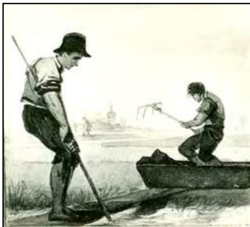
Het zwaarste werk bij de turfwinning bestond uit het ophalen van het veenslijk met de baggerbeugel en het bewerken van de veenkluiten met de klauw. (SARM)
