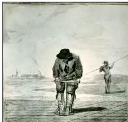
Het steken van de inmiddels ingedroogde turf. De turfmeter met een roedestok met een lengte van één roede (3,767 meter) meet de oppervlakte van de gebaggerde turf op. Op de achtergrond ligt de turfeiker, voor vervoer van de turf naar de klanten in de stad. (SARM)
