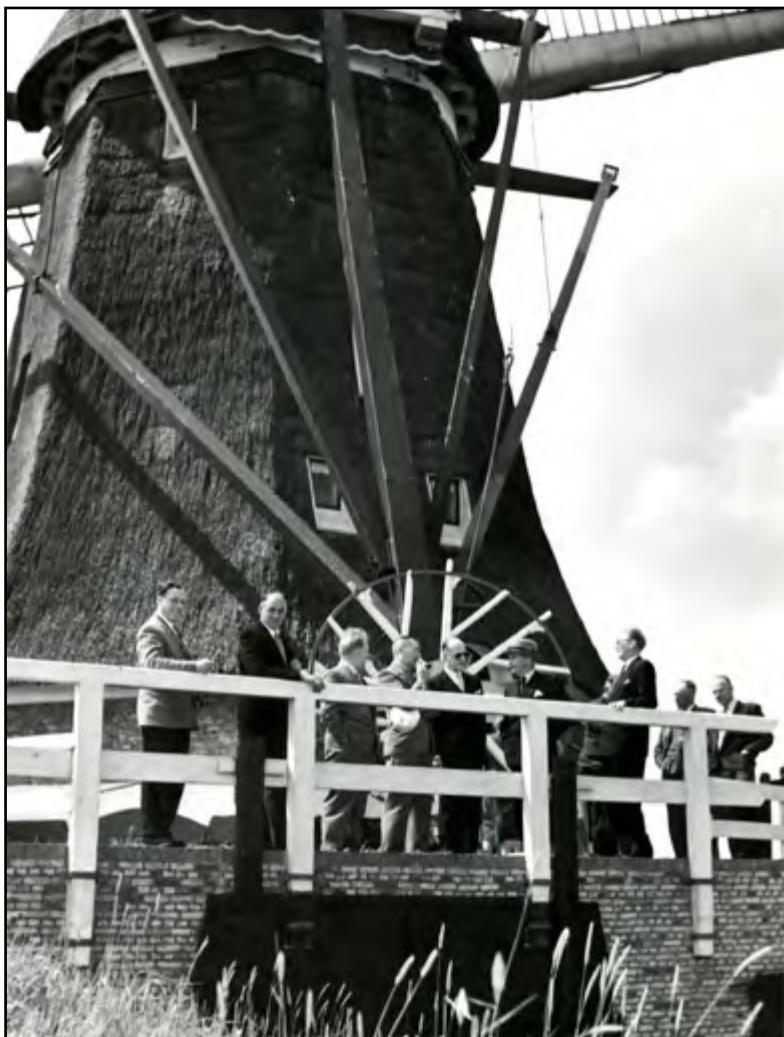
Polderbestuurders en andere genodigden bij de overdracht van molen nr. 2, die 'op het oog' werd rechtgezet. Later bleek dat dit rechtzetten geen resultaat had en het verzakken doorzette. (SARM)
