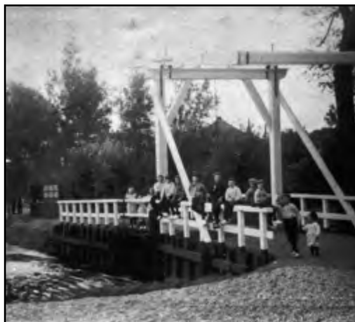
Ook in het Kerkvaartspad (de huidige Kerkvaartsweg) moest een brug worden aangelegd, omdat het pad hier ook door de nieuwe ringsloot werd doorsneden. (collectie A.J.J. van 't Riet)
